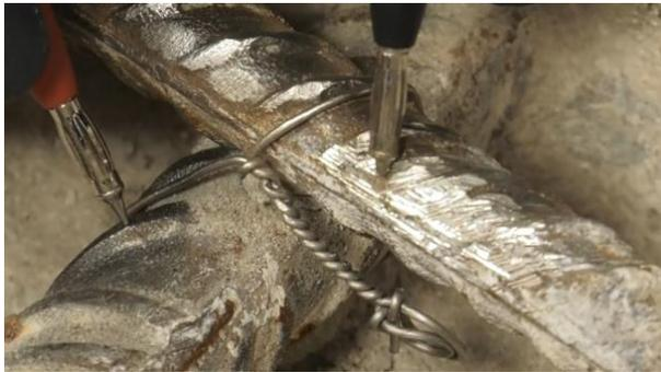
3. Taladrar hoyos de 25 mm (1") con la profundidad requerida en el borde de la reparación del parche (consulte la tabla) asegurándose de evitar el contacto con el acero. Eliminar el exceso de polvo usando una aspiradora para removerlo del hoyo.
