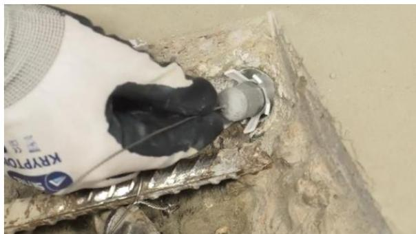
6. Conecte el PatchGuard™ con el alambre del ánodo (como mínimo 2 veces) alrededor de la barra de acero pre-limpiada y ajustándola con cuidado usando pinzas. Esta conexión es esencial para el funcionamiento de los ánodos. Una vez que se complete la conexión, asegure el cable a la barra de refuerzo utilizando dos bridas de plástico.
