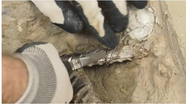
7. Aplique una pequeña cantidad de mortero de reparación para tapan el ánodo si la reparación no será completada en mas de 2 horas.
